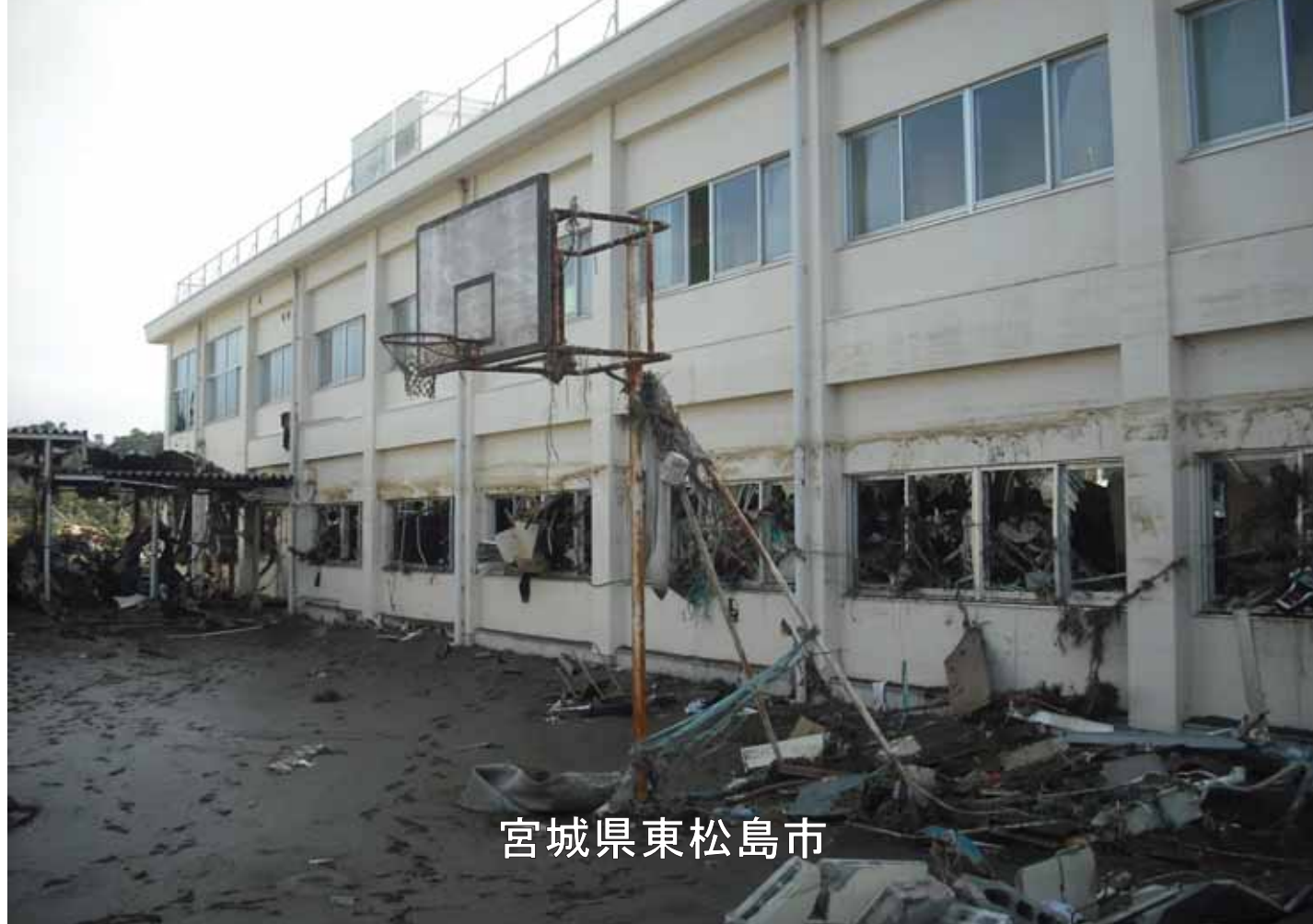
2004_2_018_020018_東松島市_2011.3.14_鳴瀬第二中学校
