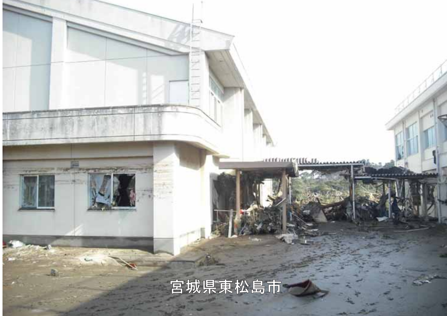
2004_2_018_020017_東松島市_2011.3.14_鳴瀬第二中学校
