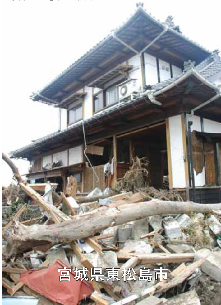
1903_2_018_009914_東松島市(広報)_2011.3.15_ 野蒜地区_東名新場
