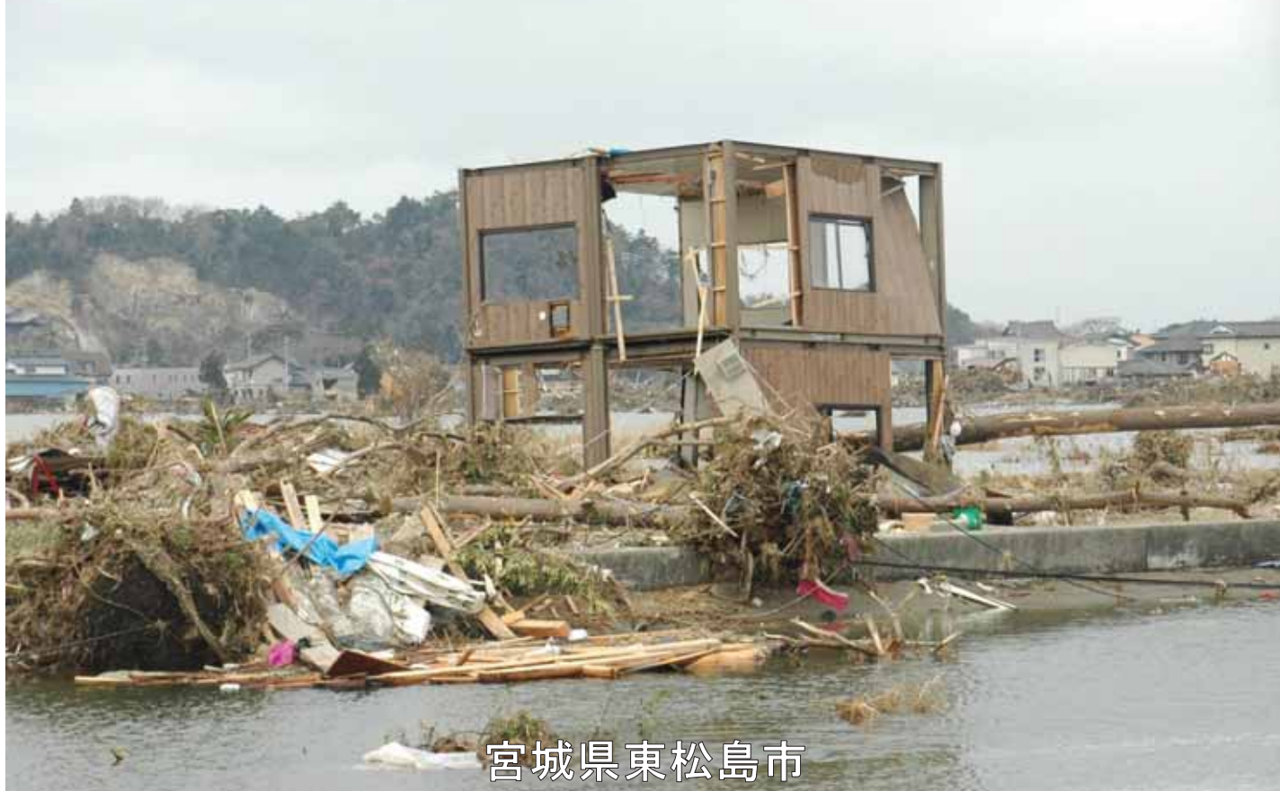
1903_2_018_009884_東松島市(広報)_2011.3.15_野蒜地区_東名新場
