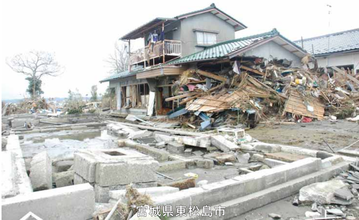
1903_2_018_009883_東松島市(広報)_2011.3.15_野蒜地区_東名新場
