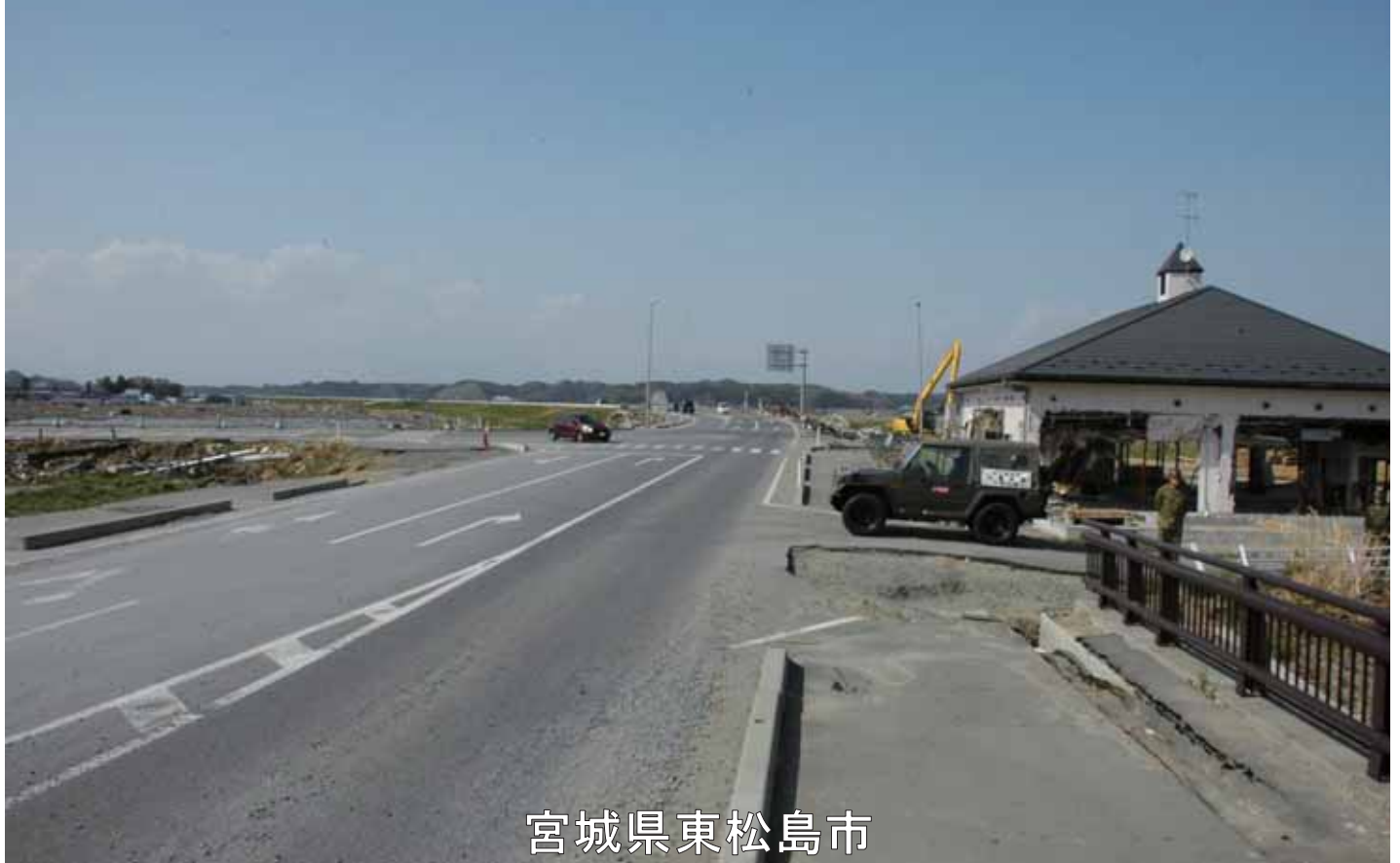
1702_3_018_016209_東松島市(広報)_2011.5.4_野蒜地区_新町_矢本消防署鳴瀬出張所前
