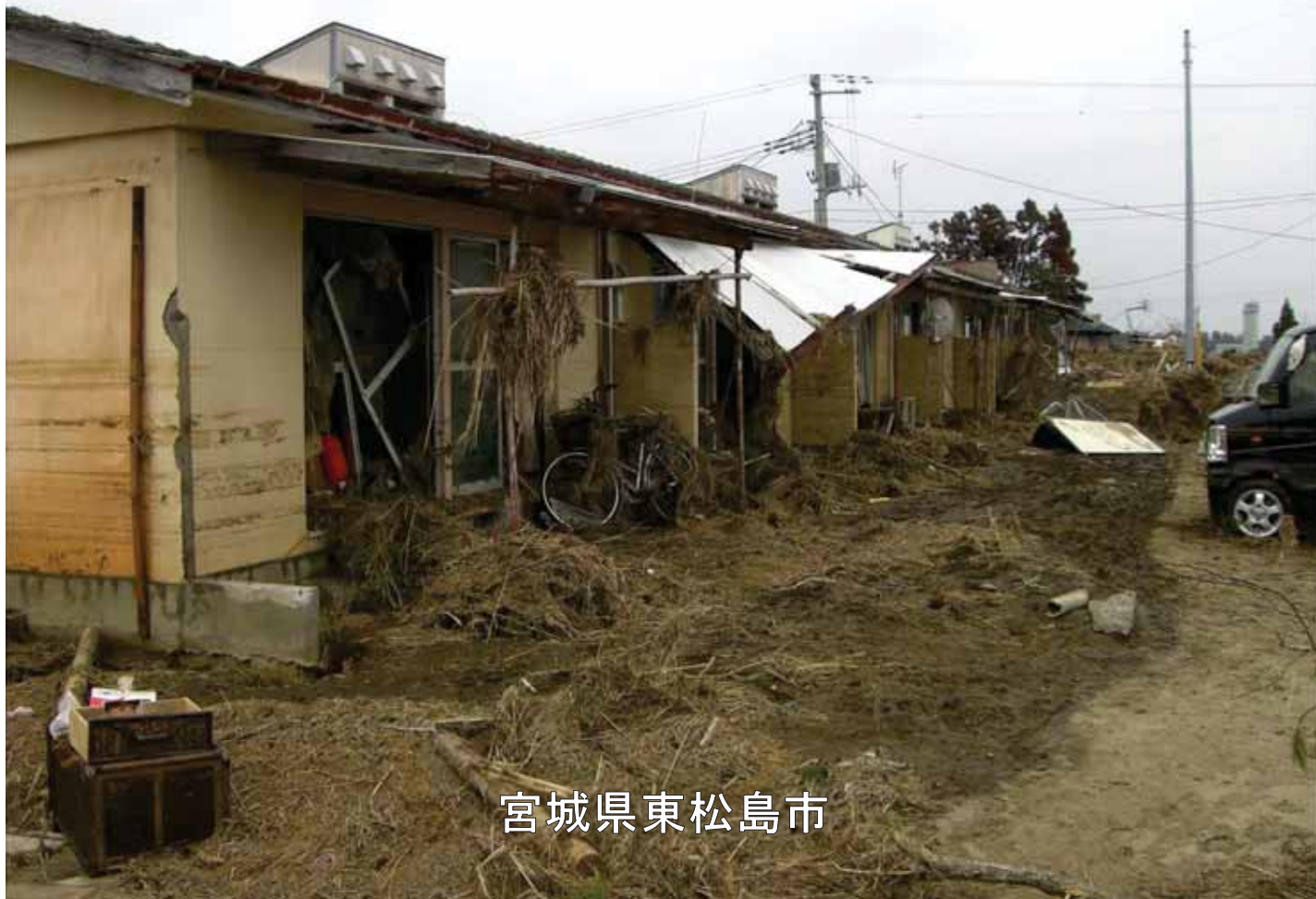
0504_2_018_018680_東松島市_2011.3.15_市営立沼住宅
