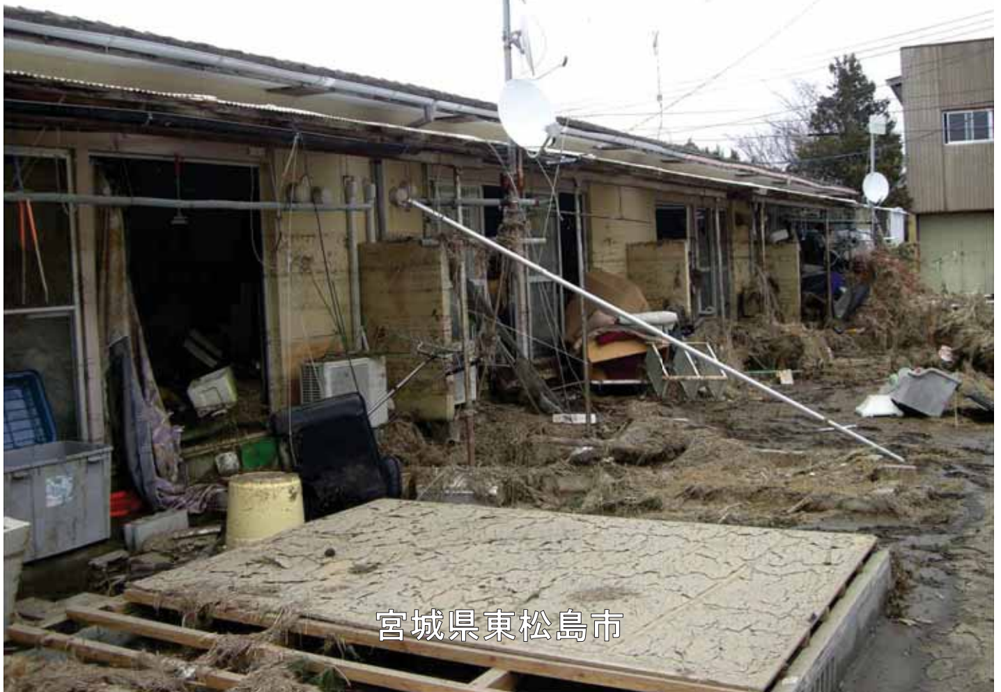
0504_2_018_018685_東松島市_2011.3.15_市営立沼住宅
