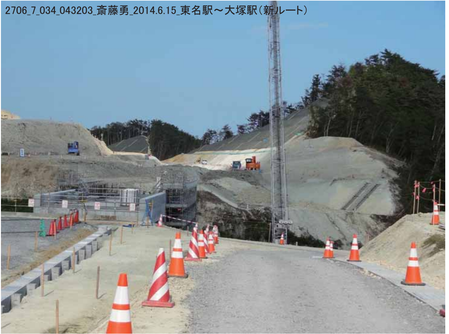
2706_7_034_043204_斎藤勇_2014.6.15_東名駅～大塚駅(新ルート)
