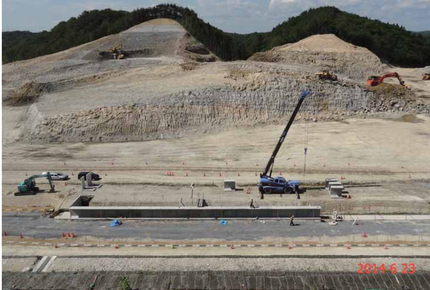
2706_7_034_043210_斎藤勇_2014.6.23_東名駅～大塚駅(新ルート)
