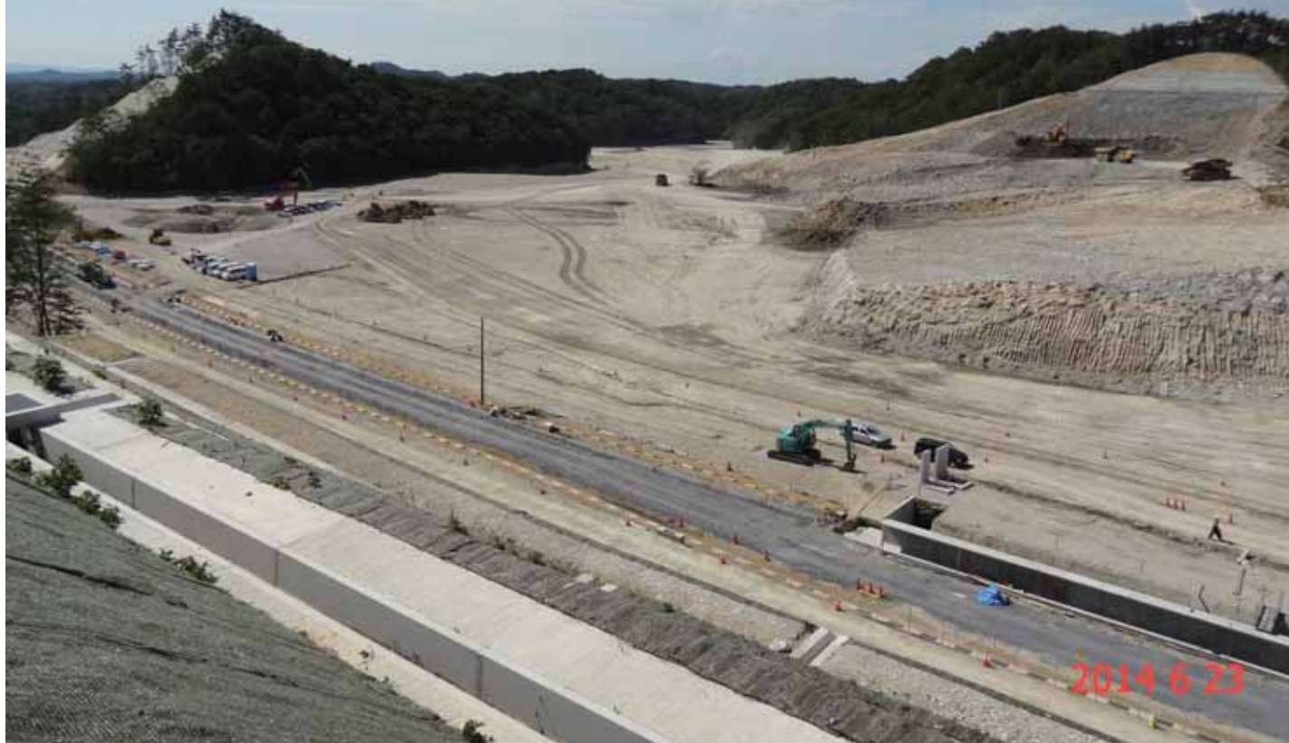
2706_7_034_043212_斎藤勇_2014.6.23_東名駅～大塚駅(新ルート)
