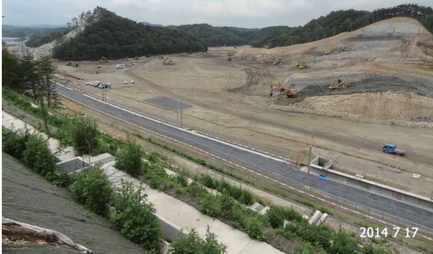
2706_7_034_043223_斎藤勇_2014.7.17_東名駅～大塚駅(新ルート)
