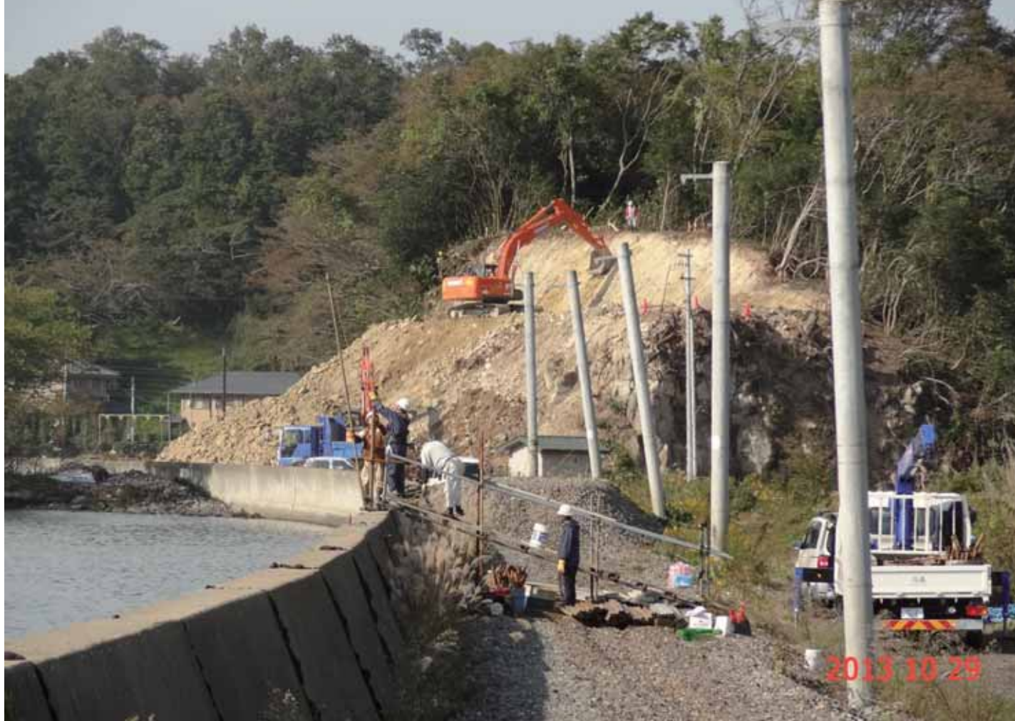
2706_6_034_043227_斎藤勇_2013.10.29_東名駅～大塚駅_大塚駅付近_かさ上げ
