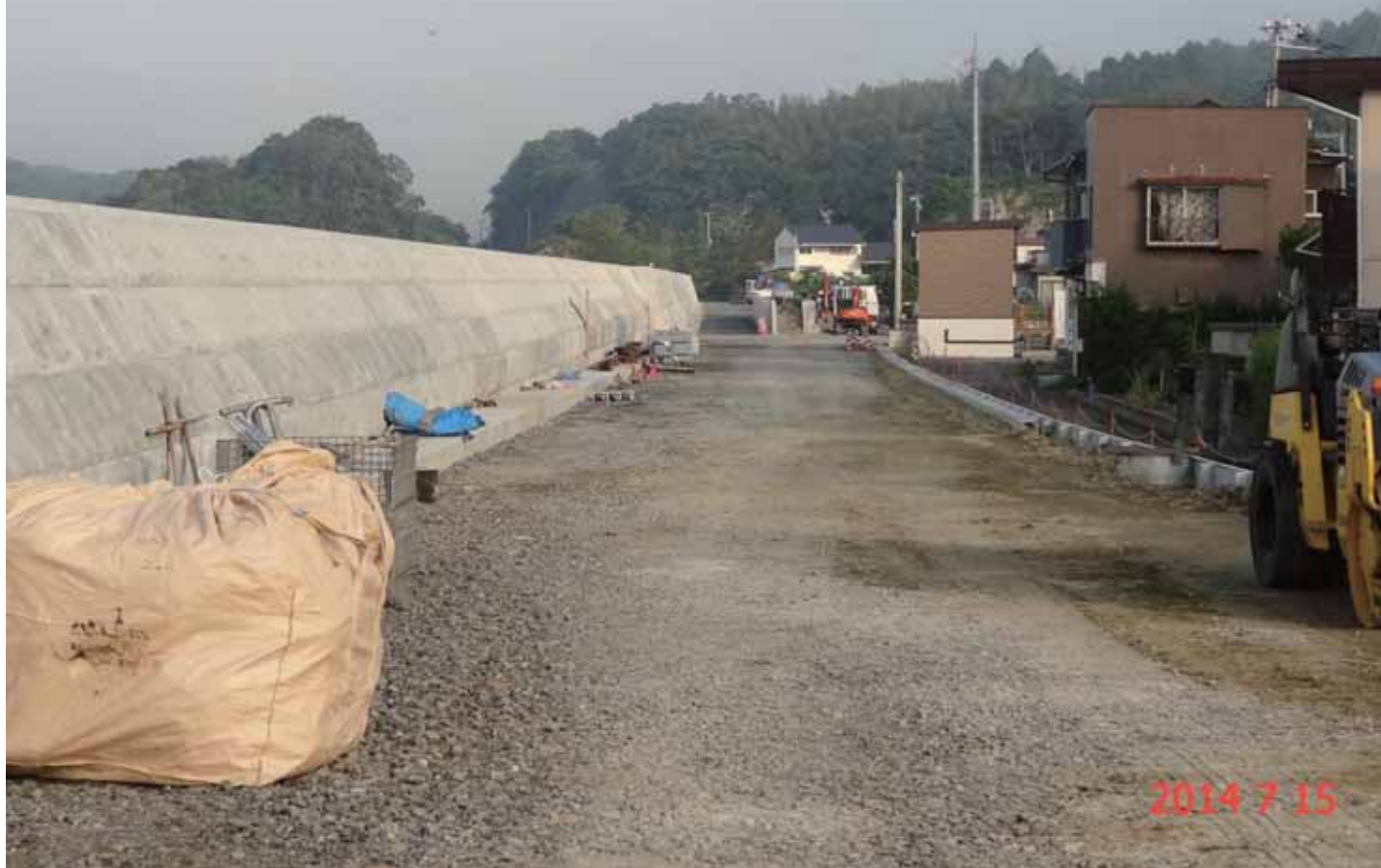
2706_7_034_043217_斎藤勇_2014.7.15_東名駅～大塚駅_大塚駅付近_かさ上げ
