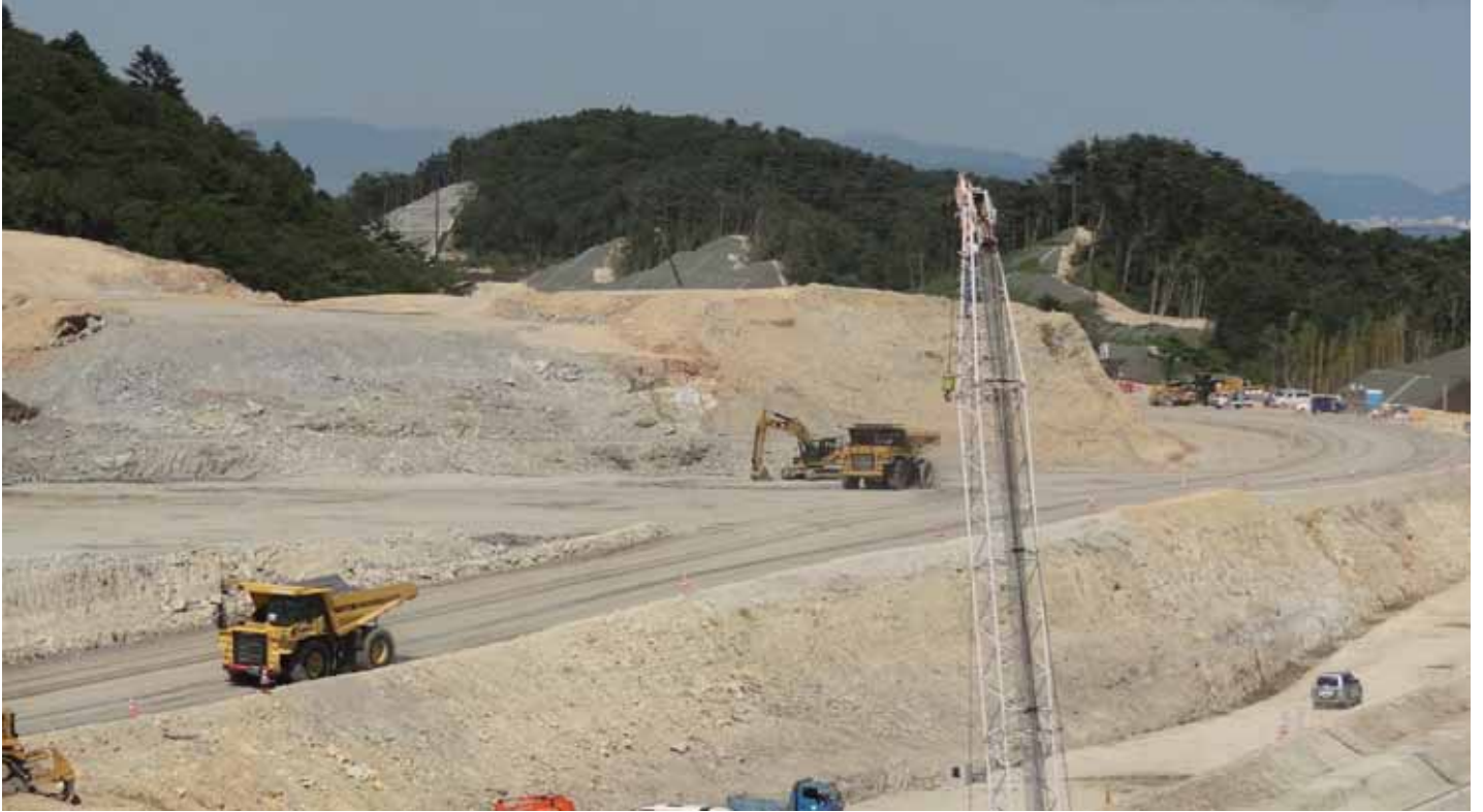
2706_7_034_043208_斎藤勇_2014.6.23_東名駅～大塚駅(新ルート)
