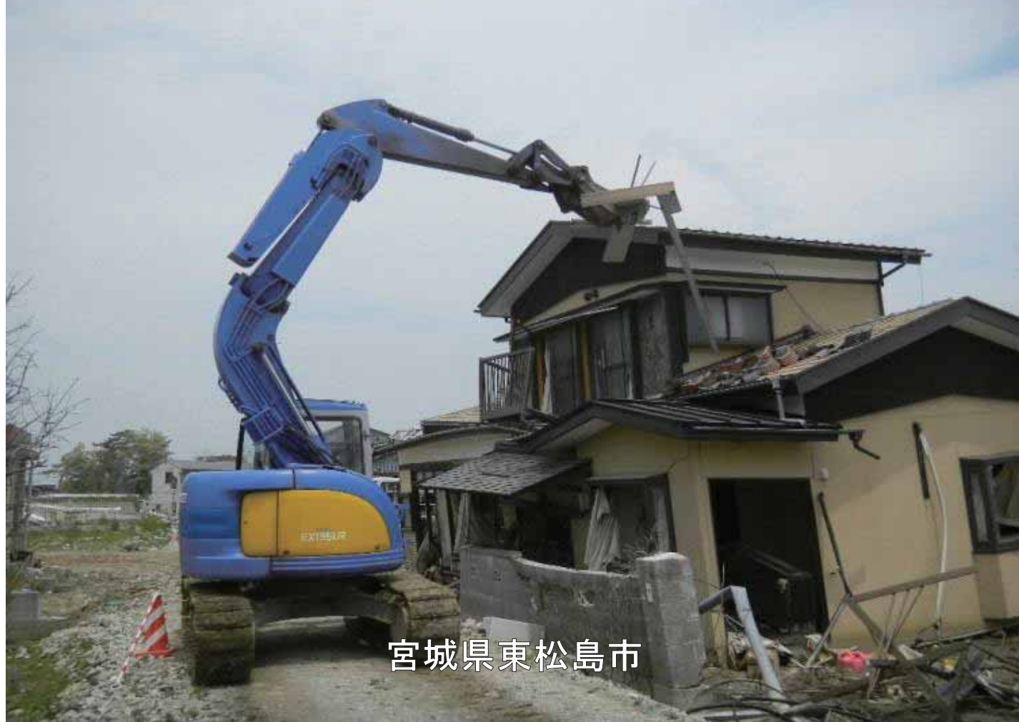
2615_4_018_044878_東松島市_2011.6.9_家屋解体
