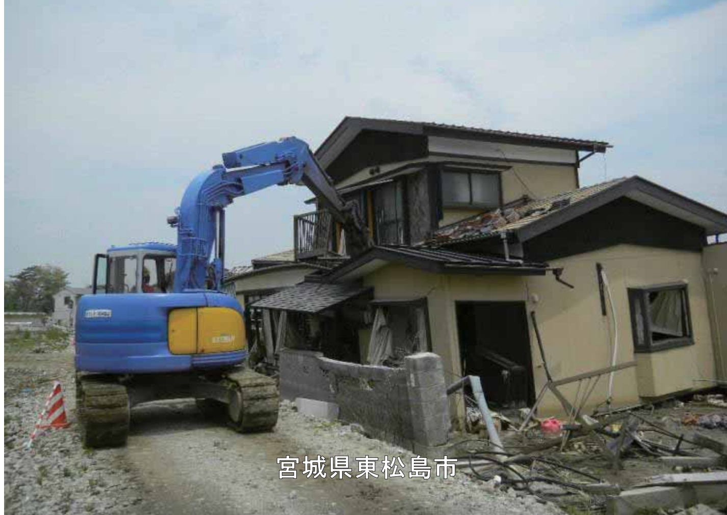
2615_4_018_044877_東松島市_2011.6.9_家屋解体
