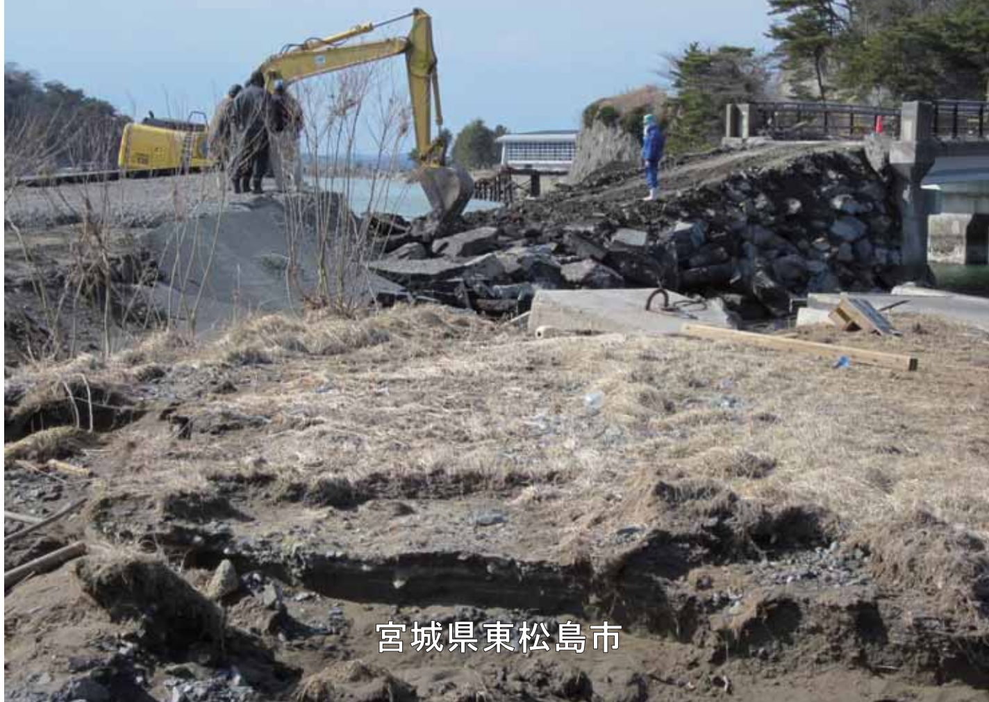
2202_2_031_038121_東松島市図書館_2011.3.24_松ヶ島橋復旧工事
