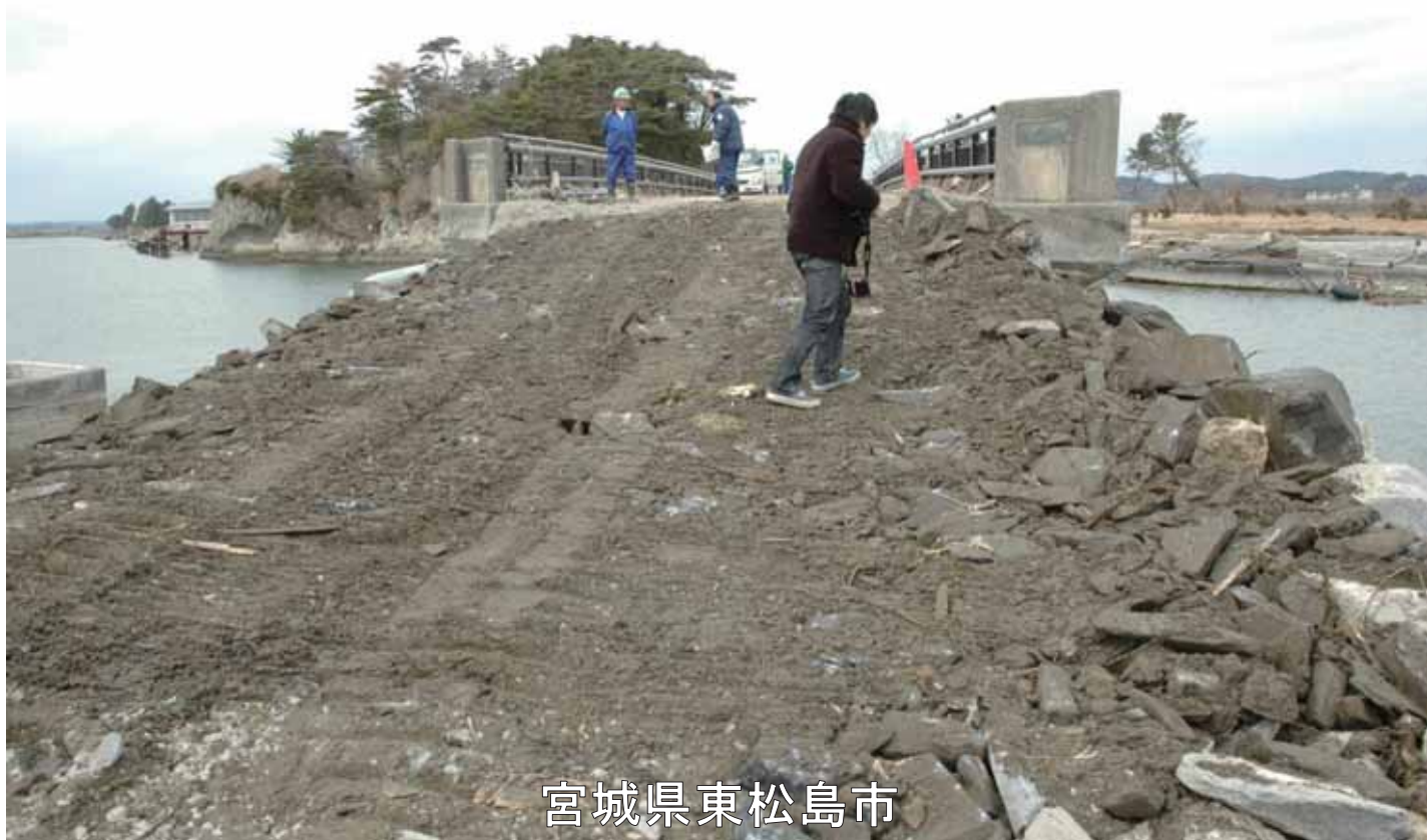
2202_2_018_011685_東松島市(広報)_2011.3.25_松ヶ島橋復旧
