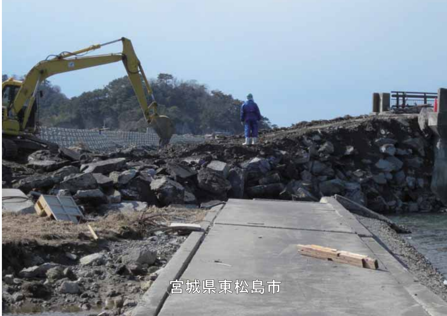
2202_2_031_038122_東松島市図書館_2011.3.24_松ヶ島橋復旧工事
