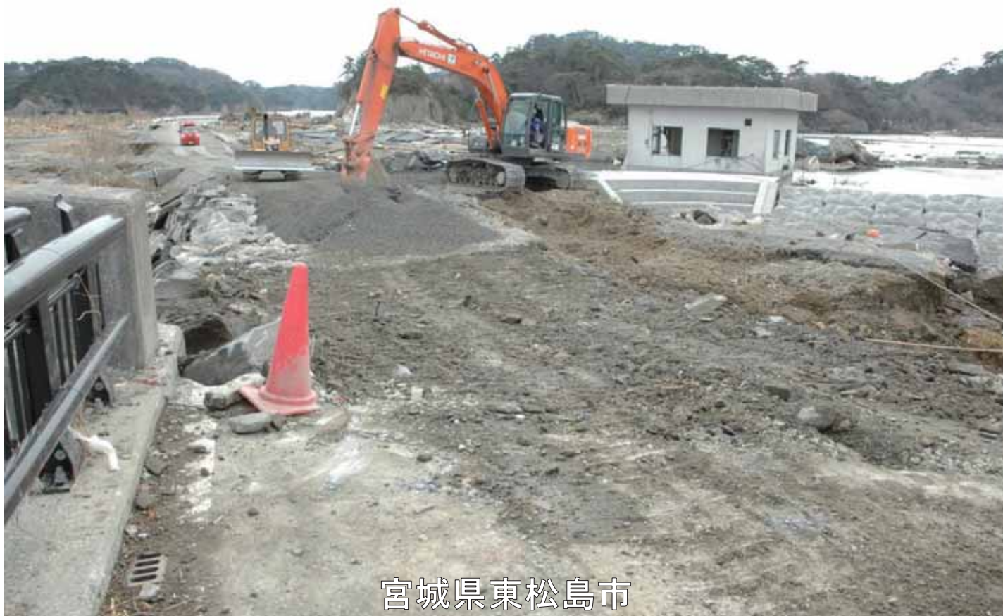
2202_2_018_011688_東松島市(広報)_2011.3.25_松ヶ島橋復旧
