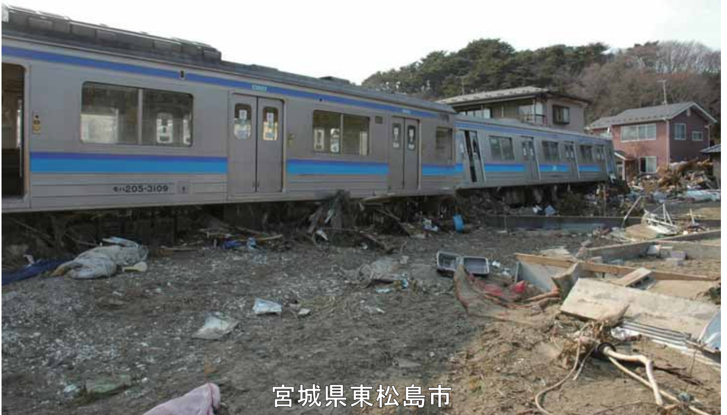
1818_2_018_012649_東松島市(広報)_2011.3.29_野蒜地区_JR仙石線被災車輛
