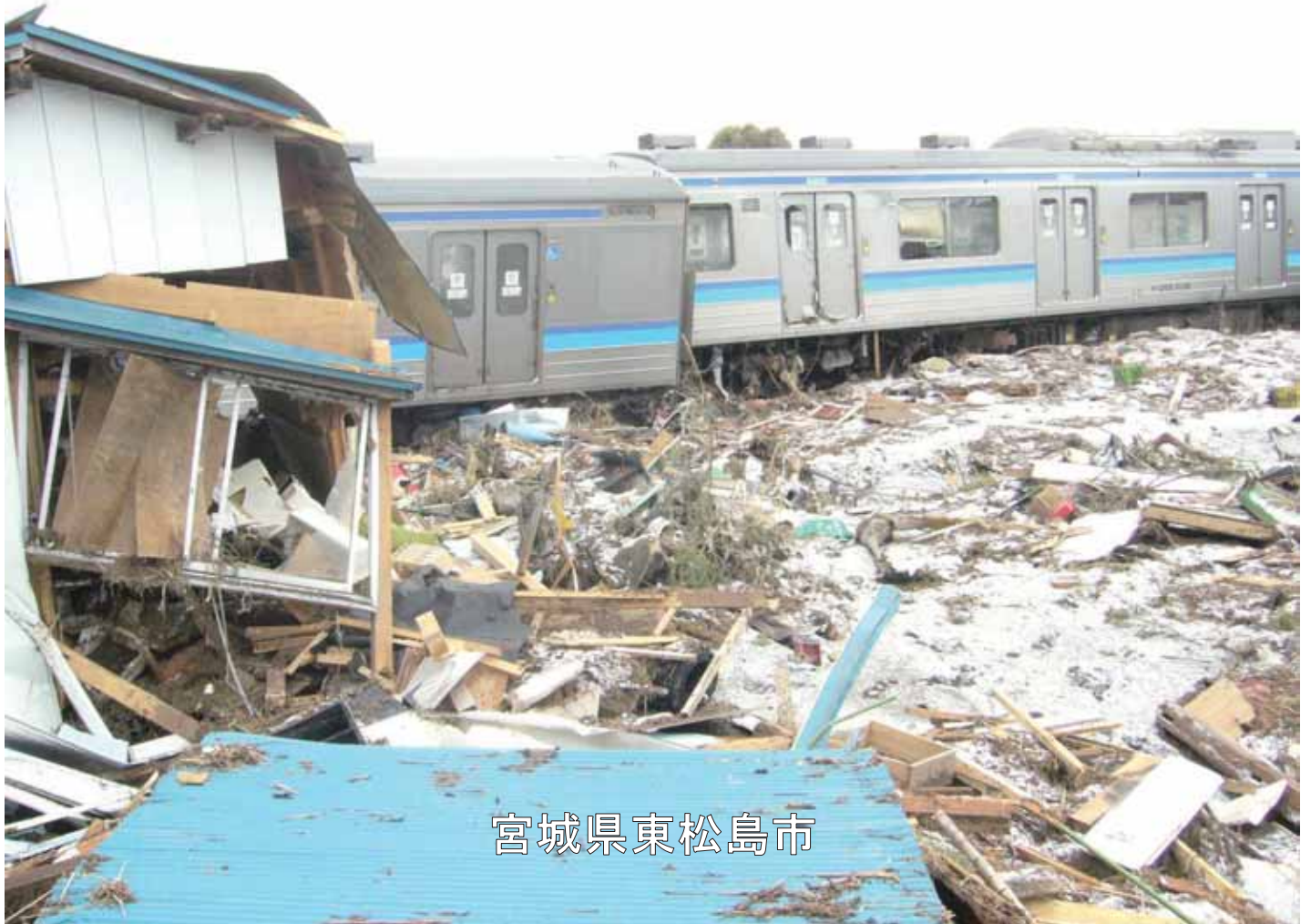
1818_2_036_045084_匿名_2011.3.17_JR仙石線被災車輛
