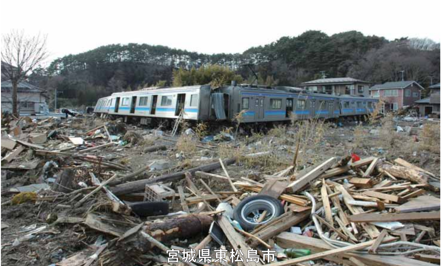
1818_2_018_012630_東松島市(広報)_2011.3.29_野蒜地区_JR仙石線被災車輛
