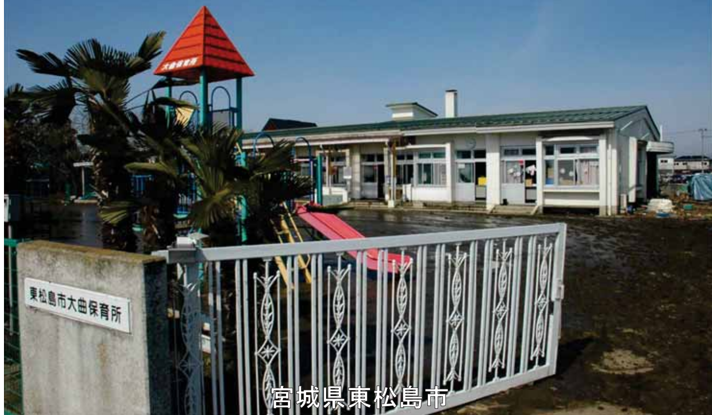
0922_2_018_009063_東松島市(広報)_2011.3.14_大曲保育所_津波被害
