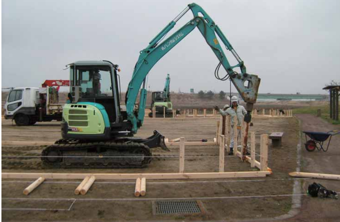
0836_3_035_043737_ 赤井市民センター_ 2011.4.22_ 仮設住宅設置
