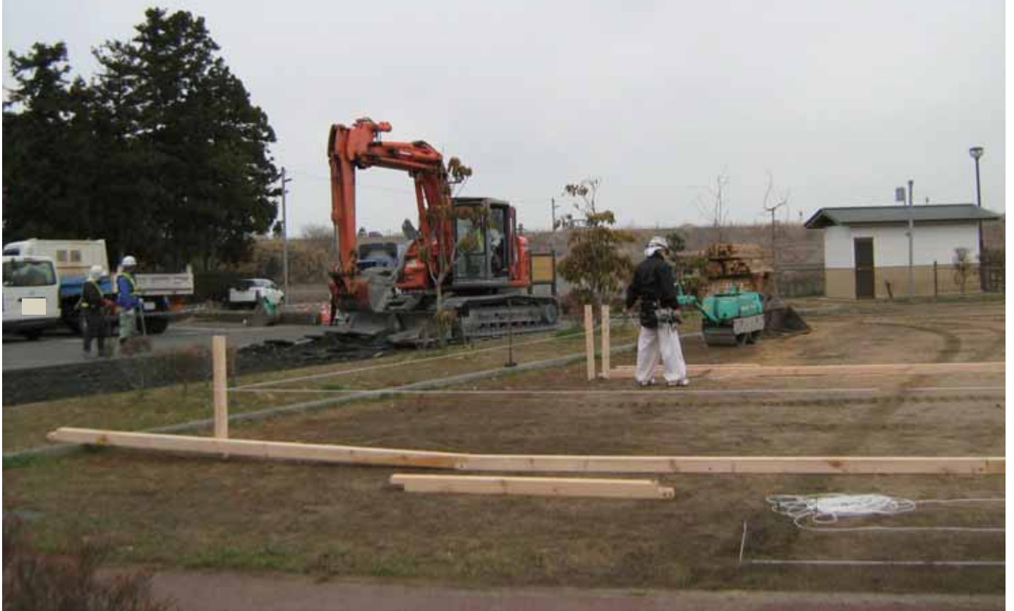
0836_3_035_043733_赤井市民センター_2011.4.22_仮設住宅設置
