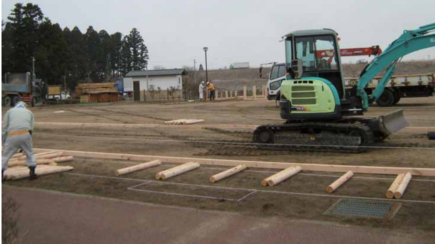
0836_3_035_043731_赤井市民センター_2011.4.22_仮設住宅設置
