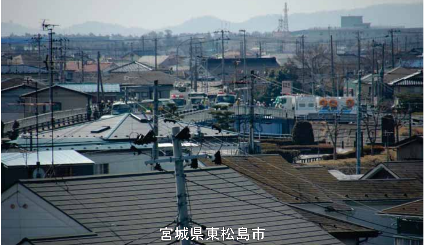
0101_2_018_008516_東松島市(広報)2011.3.14_赤井地区_ 国交省排水作業(国道定川橋・三浦食堂・大曲小学校)
